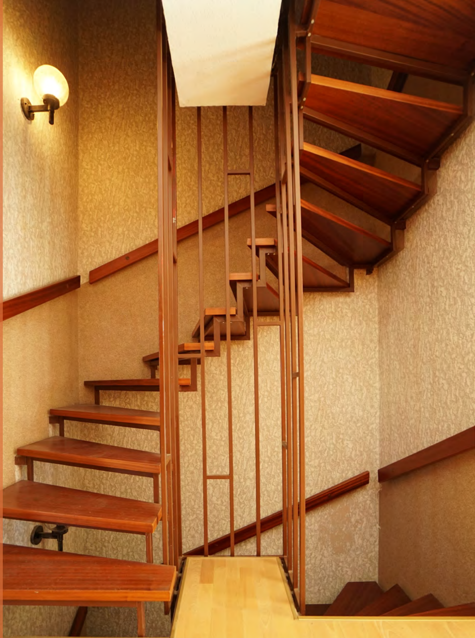
TREPPE INS OG
